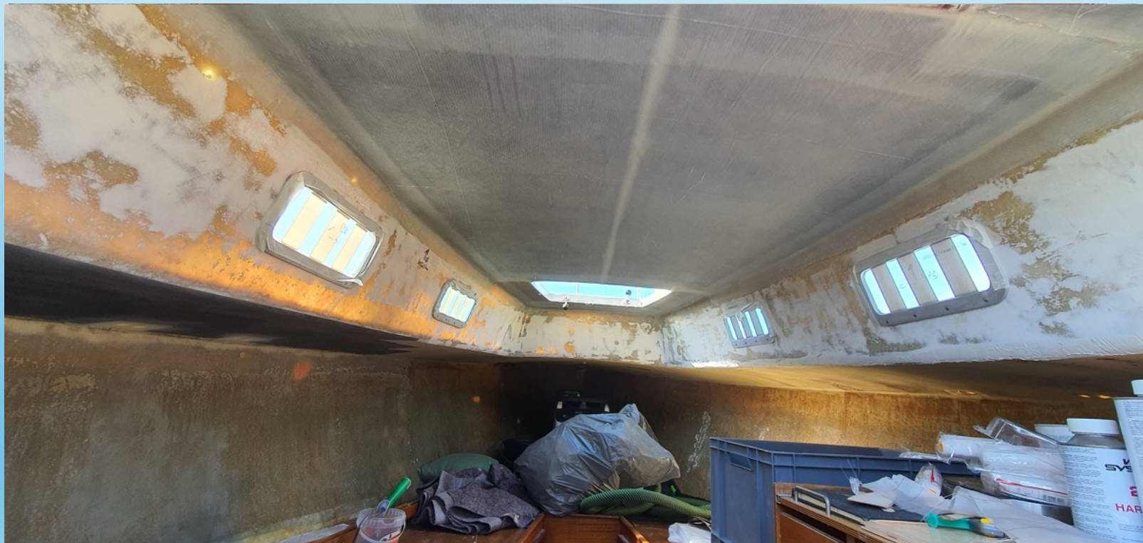
Sandwichdecksanierung Spaeck 187
